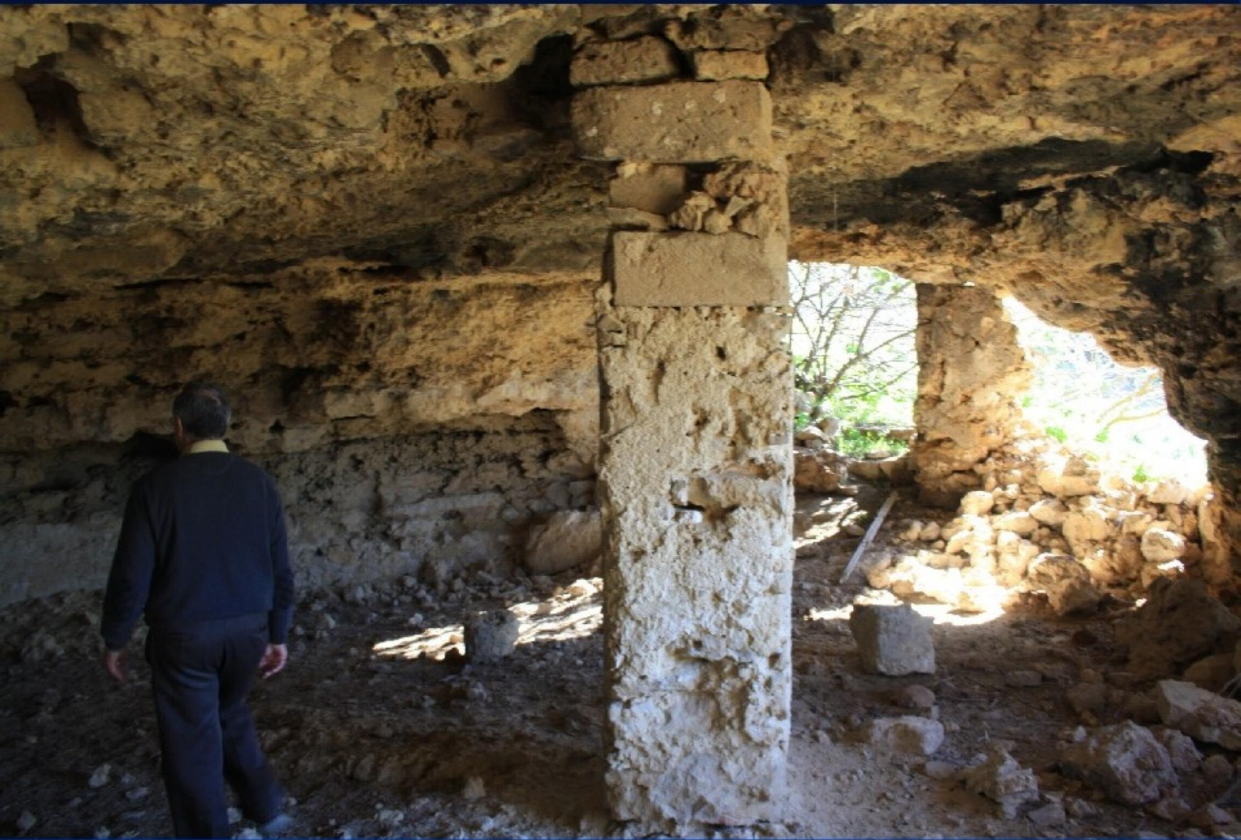
**In via cautelativa, un puntello in conci di calcarenite, “sostiene” la volta.**
