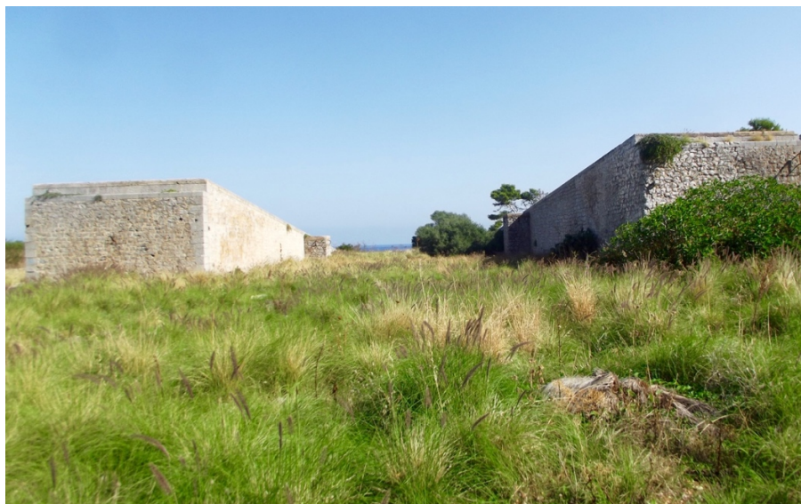
Uno degli scali di alaggio dell'ex Cantiere Roma (vista posteriore).
